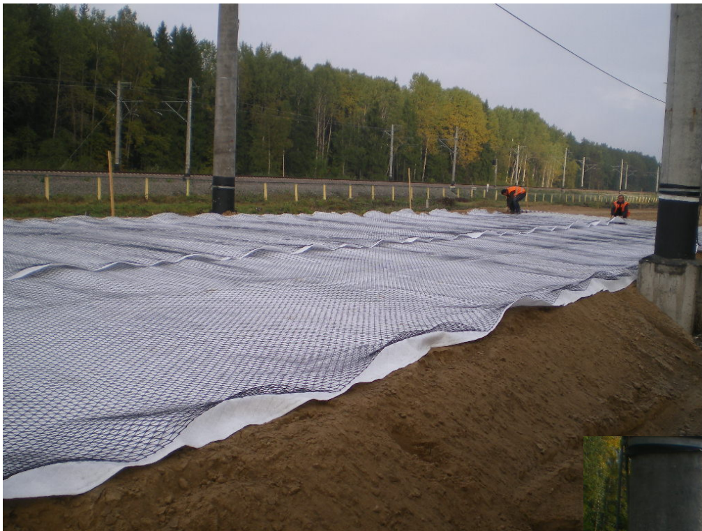
Укладка в ходе реконструкции геокомпозита Tensar TX170G
